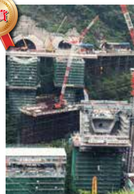
「東名のトンネル工事を見学して」 瀬戸 大和（5年）
